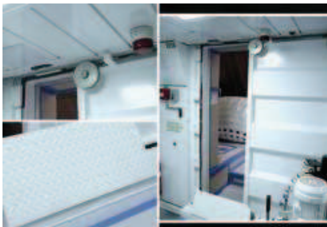
Porte stagne installate a bordo della m/n Koningsdam
